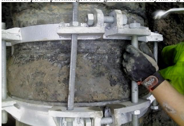
Figur 5:8 Gängstänger monteras.
