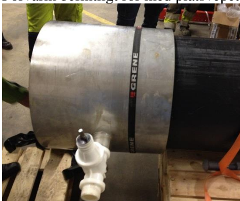
Figur 7:1 Ångjanne på befintligt PE-rör.
