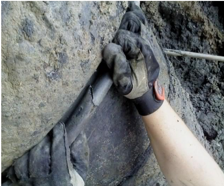
Figur 1:9 Snedskuren O-ring monteras vid skarv.
