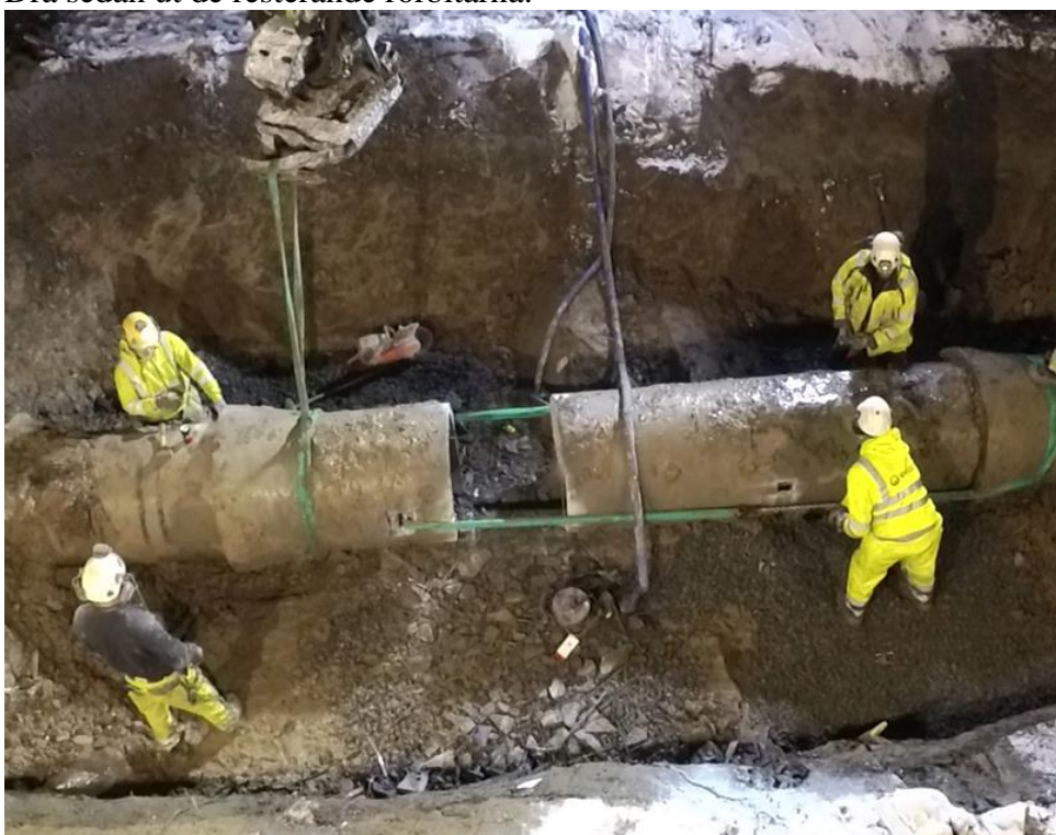
Figur 1:2 Rörbitarna dras loss med hjälp av stropp och dragblock
