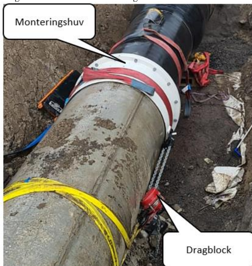
Figur 1:6 Monteringshuv spelas på plats med dragblock.
