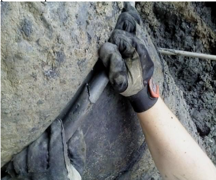
Figur 5:6 Kapning och limning av gummipackning.
