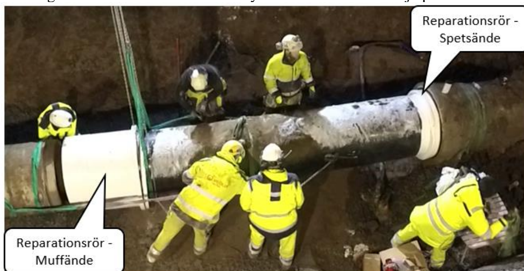
Figur 1:4 För att få riktningen korrekt kan det vara bra att ha ett dragblock på lyftstropparna för manuell rikning vid höjning och skänkning av röret.
