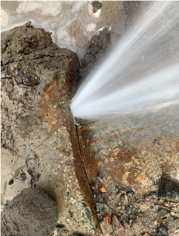
Figur 1:7 Läckande Sentabskarv.
