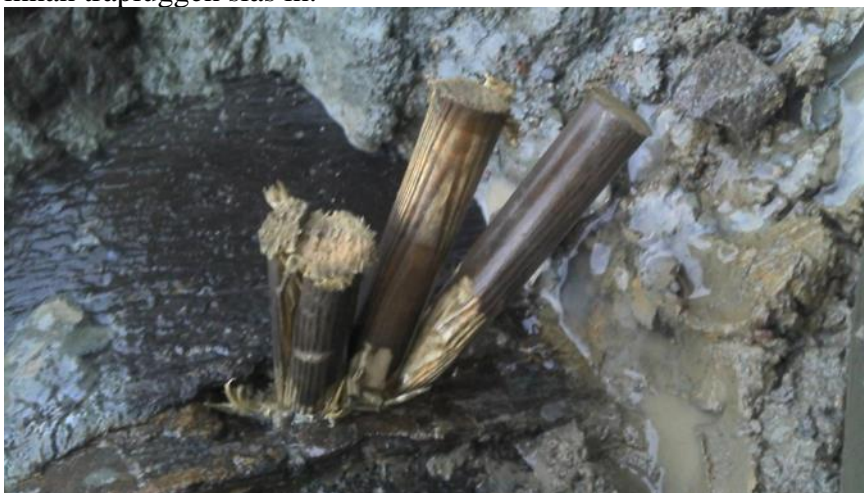
Figur 5:1 Träpluggar slås in i hålet.
