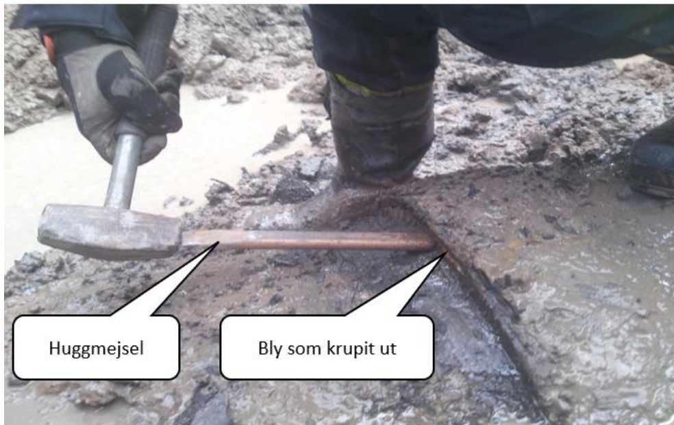
Figur 5:5 Diktning av blyskarv
