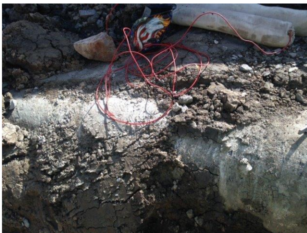
Figur 5:4 Offeranoder ansluts till skruven.
