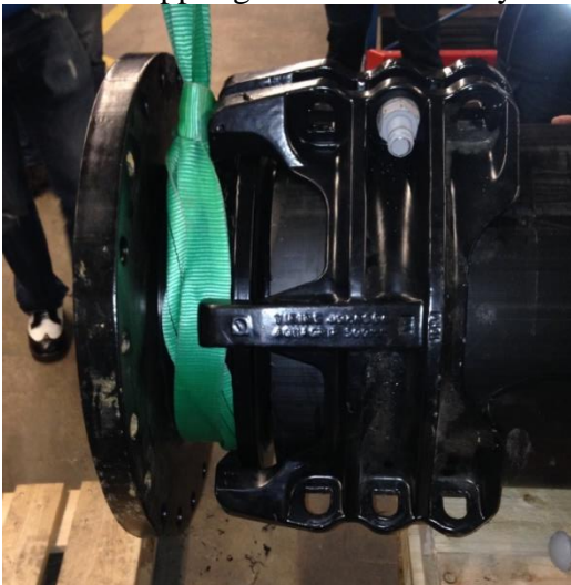
Figur 7:4 Kopplingens yttre del monteras utanpå PE-röret.
