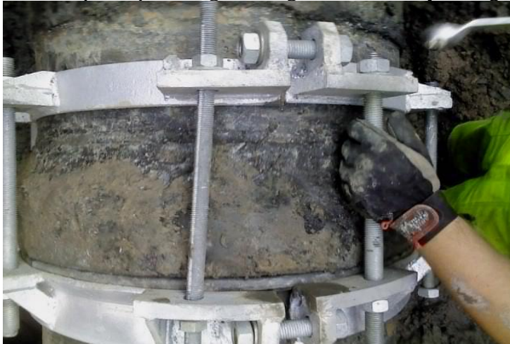
Figur 1:11 Gängade stänger monteras
