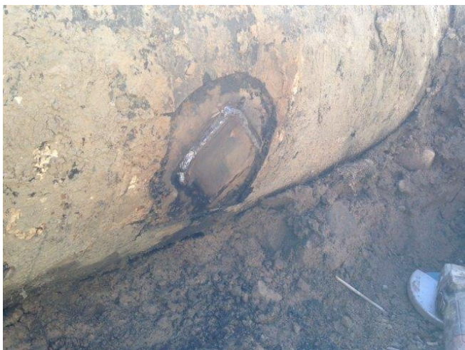
Figur 5:2 Fastsvetsat plattjärn.
