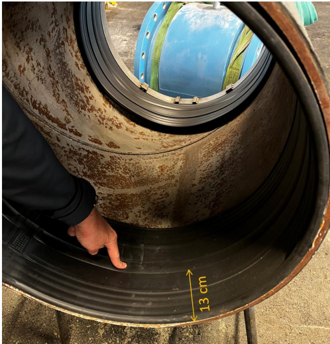
Figur 8:1 Det är viktigt att kapa exakt 13 cm från rörändan.
