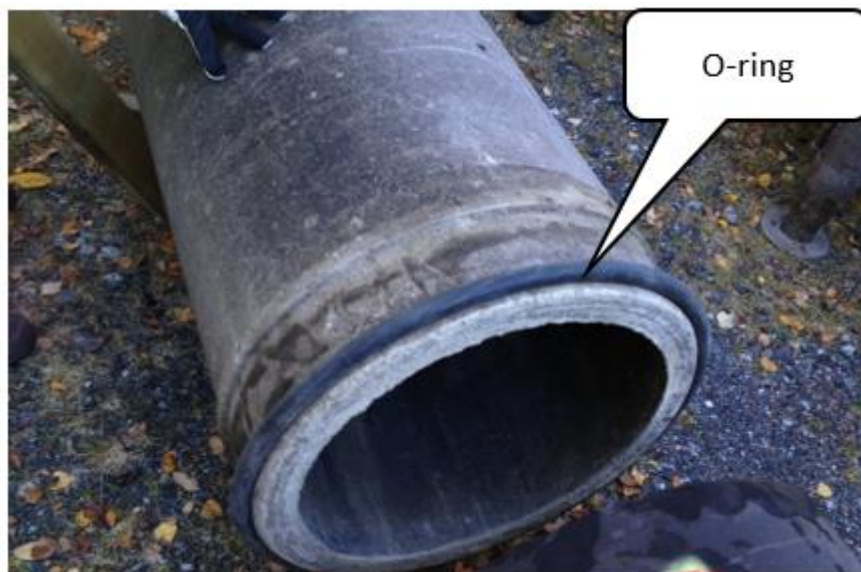
Figur 1:5 O-ring monteras på befintligt Sentabrör.
