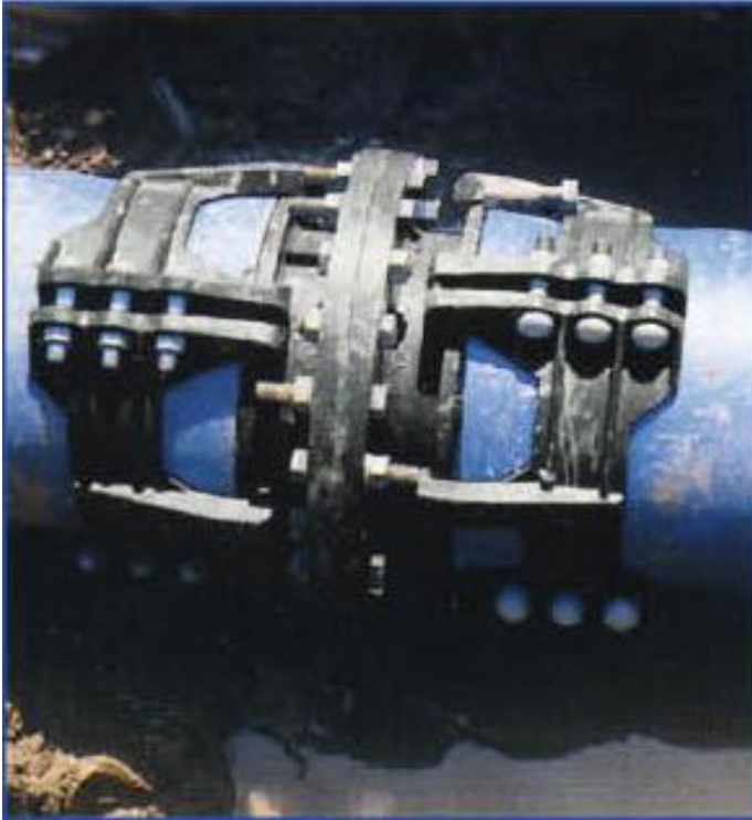
Figur 7:5 Det båda PE-rören monteras ihop med flänsförbandet.
