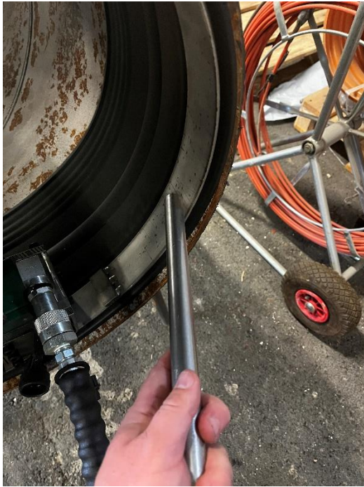
Figur 8:5 Metalpinne används för att slå på end seal.
