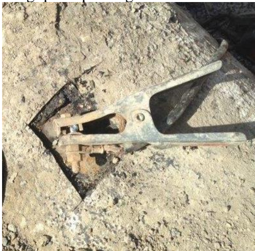
Figur 5:3 Skruv för montering av offeranoder svetsas på stålröret.
